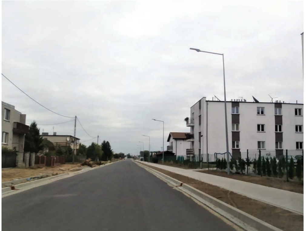
Wyremontowana droga Zakrzew - Golina.
